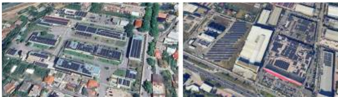
Fig. 170: Instalimi i impianteve të paneleve fotovoltaike në subjektin PROFARMA sh.a. dhe në Fabrikën e miellit ATLAS dhe të kompleksit tregtar të QTU.
