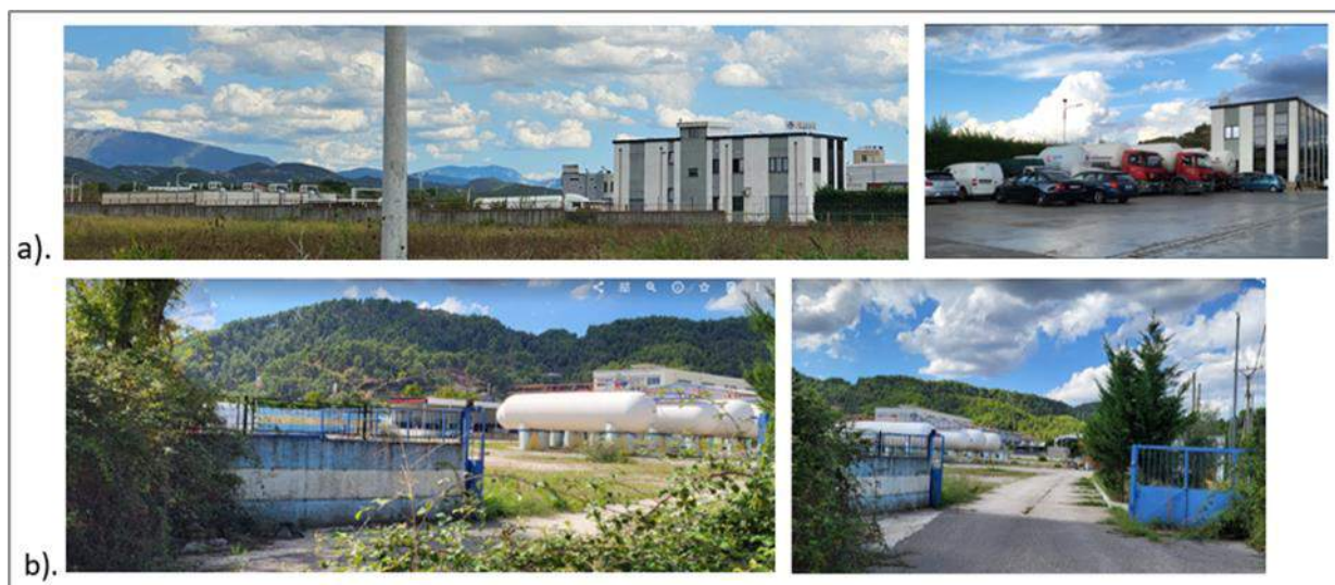
Fig. 183: a).Selia dhe Instalimet e depozitave te GLN shoqëria AV GAZ Distribution sh.a.; b). Impianti i depozitimit të Gaz Group sh.a. - Vaqarr
