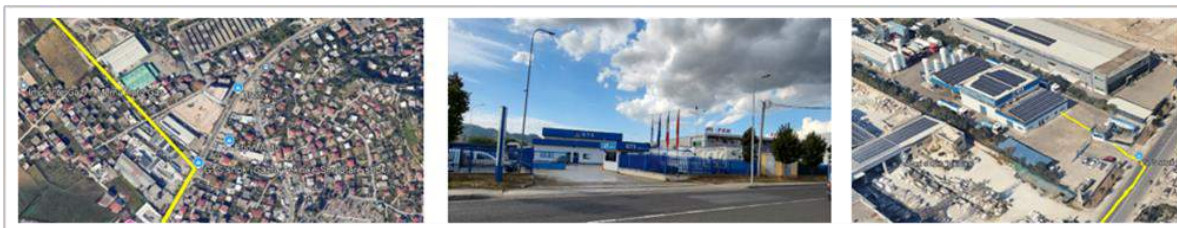
Fig. 157: Impianti i Gazit Teknik – Vaqarr
