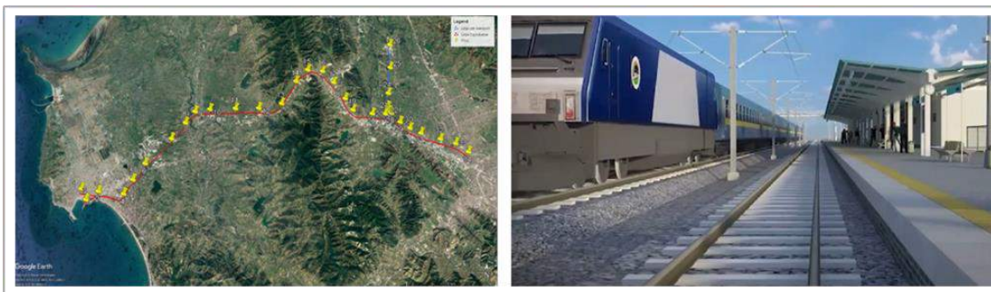
Fig. 211: Projekti i hekurudhës Durrës-Tiranë Projekti 3D i hekurudhës (burimi: shqiptarja.com) dhe linjës së re për në Aeroportin e Rinasit (TIA) https://hekurudha.al/linja-hekurudhore-tirane-durres
