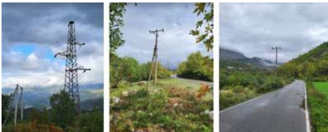
Fig. 245: Linja transmetimi tensioni i lartë dhe tensioni i ulët dy fazor në Qafë Priskë, si dhe në territorin e NJA Shëngjergj)
